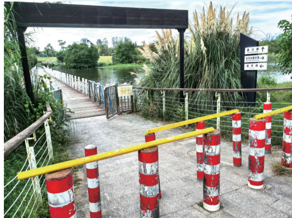
浮桥两侧都安装了安全阻拦装置。
