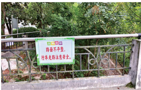
桥面上设置了提示牌。
