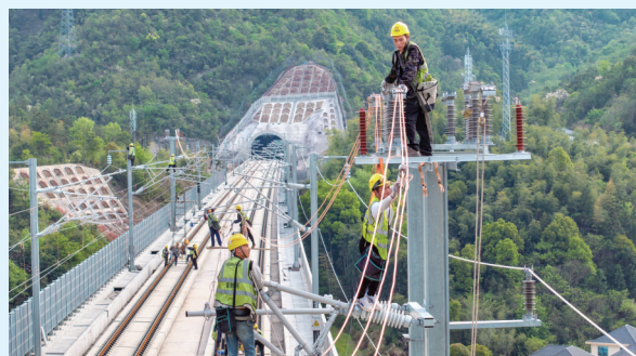
工人正在进行接触网碗臂安装。
